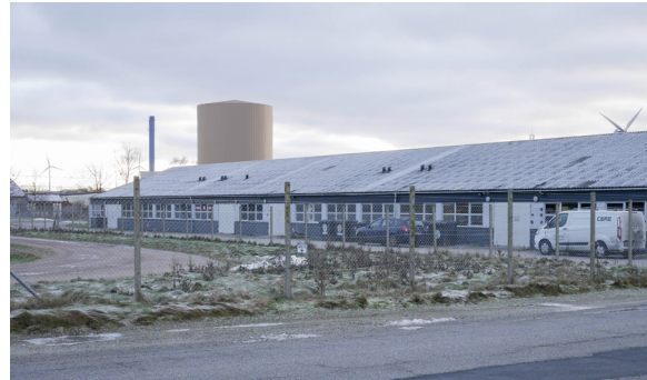
4. Efter, tanken ses i hen over taget på bygningen
