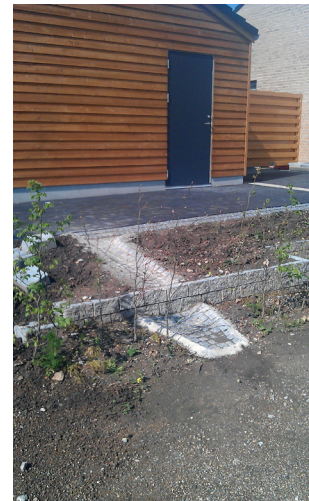
Eksempler fra Trekroner på afledning af regnvand fra privat grund til fællesarealerne.
