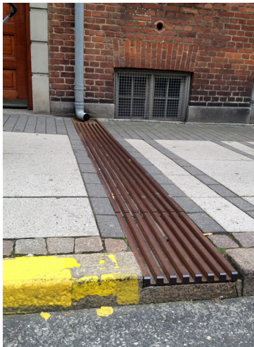
Eksempler fra Trøjborg, Aarhus, på håndtering af regnvand over gangarealer og afledning i et bestemt punkt.
