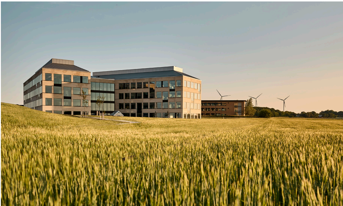
Danish Crown - Eksempel på et erhvervsbyggeri, der er opført med omtanke for de store sammenhænge i landskabet. Huset ligger synligt, når man ankommer til byen, men i harmoni med omgivelserne. Tre kontorbygninger ligger som en vifte og optager det faldende terræn og skaber samtidig et imponerende indre glasoverdækket atrium der kobler bygningerne sammen til en helhed. Fra husets atrium er der flotte kik ind mod Randers med levende marker i forgrunden.
