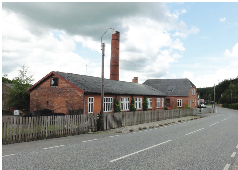
Mejeriet står stadig med intakt skorsten. Placeringen ud til Gl. Viborgvej, lige ved siden af brugsen er meget synlig. Det ville være positivt, om der kunne findes en ny funktion til de karakteristiske bygninger.
