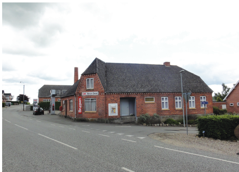
Brugsforeningens bygning ved Gl. Viborgvej er en af de mange rødstensbygninger fra andelstiden efter år 1900. Bygningerne tegner et synligt miljø i Ålum med deres placering ud til gennemfartsvejen.
