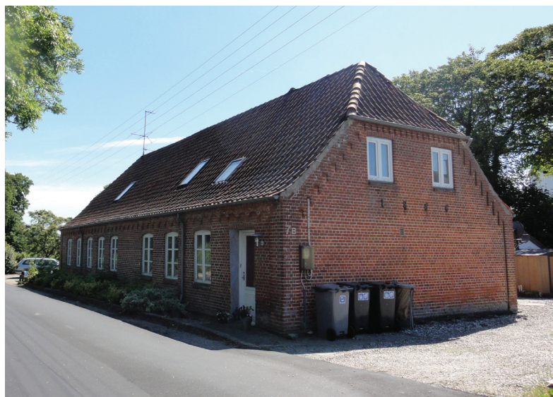
Den gamle skole, Hviddingvej 7A og B i 2010. Huset er fra 1866 og valm og murdetaljer er bevaret.
