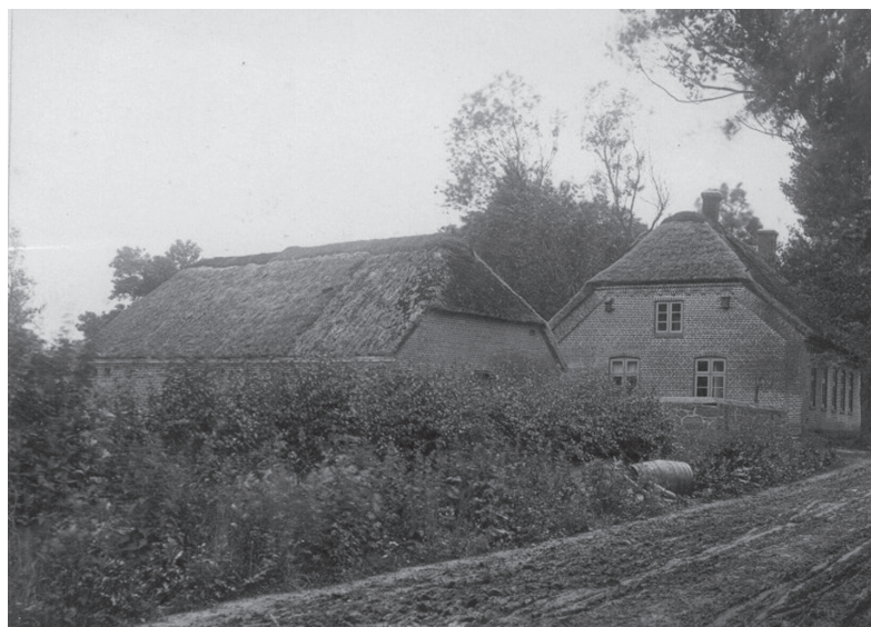
Den gamle skole, Hviddingvej 7 omkring år 1900. Blandt ændringerne er tegltag, fjernelse af to skorstene og vinduesudskiftning. At dømme efter vinduestakten er huset forlænget. Foto: Purhus Lokalarkiv
