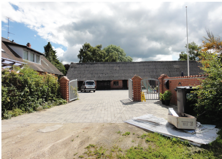
Nørreådalsvej 3 er reduceret i omfang, men der er arbejdet med at genskabe gårdens rum med en mur samt beplantning mod vest.
