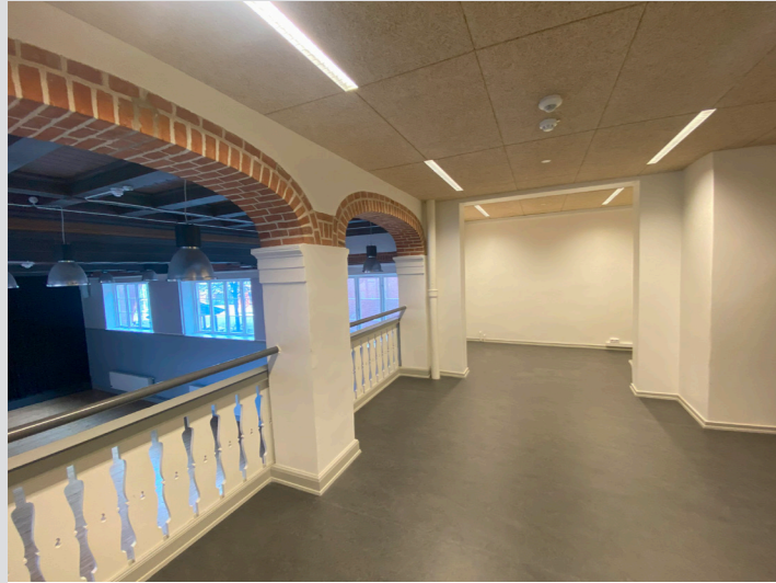
Balkon er svær at udnytte og præges af lydgener da der er direkte forbindelse til gymnastiksal og PLC. Det kan overvejes at skektionere arealerne med glasvæg.
