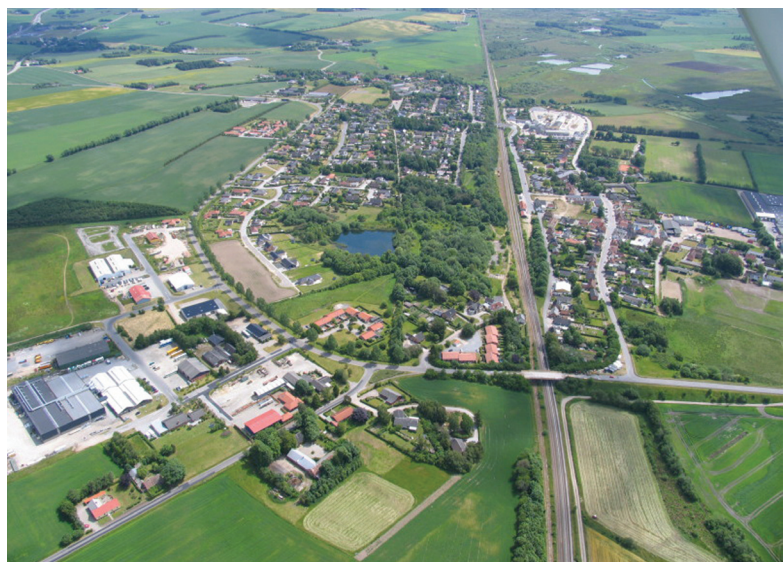
Banens kløvende effekt ses tydeligt på dette luftfoto taget mod sydøst. Bemærk den nye allé der går i en fin bue omkring parcelhusbyen. Foto: Purhus Lokalarkiv
