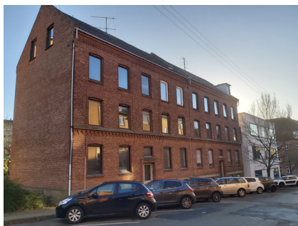
Foto af tidligere ejendom på sennelsgade 16-18 der er nedrevet
