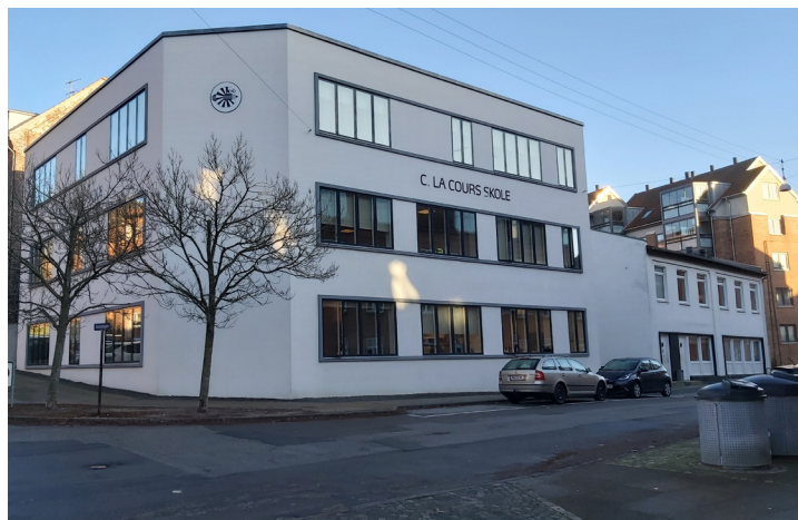
C. la. Cour skolens eksisterende bebyggelse Jyllandsgade 16A-16
