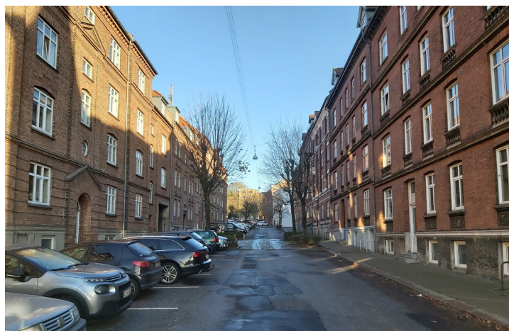
Gaden ved Sennelsgade betår af murværk i rød tegl.
