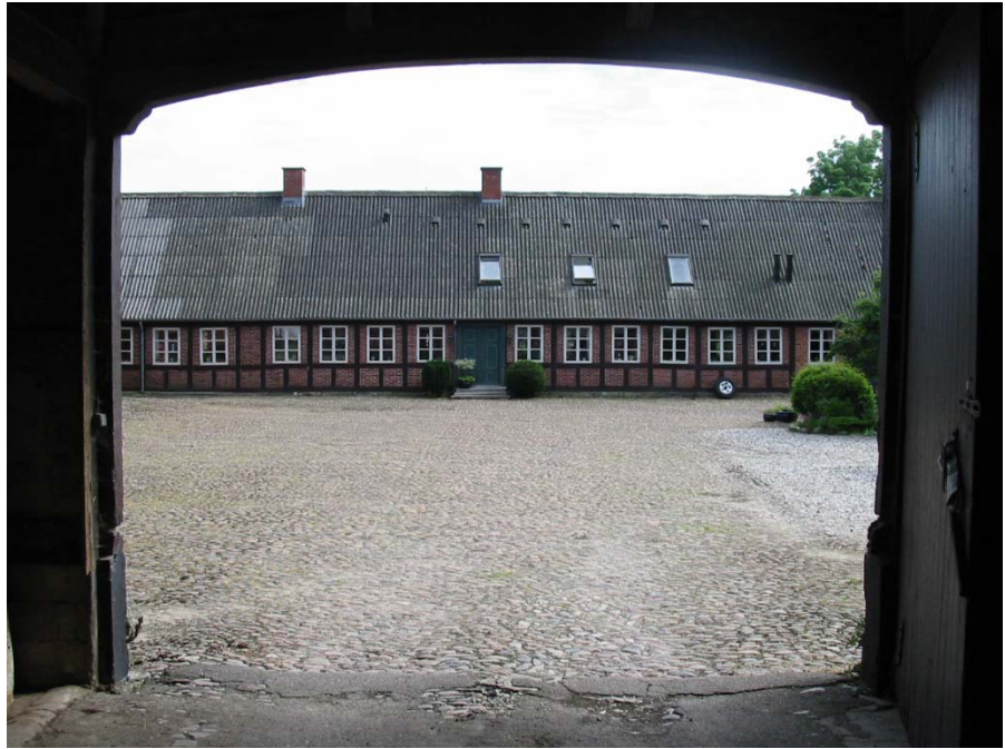
Fra ladeporten åbenbares det sluttede gårdrum med stuehusets regelmæssige vinduesfacade.
