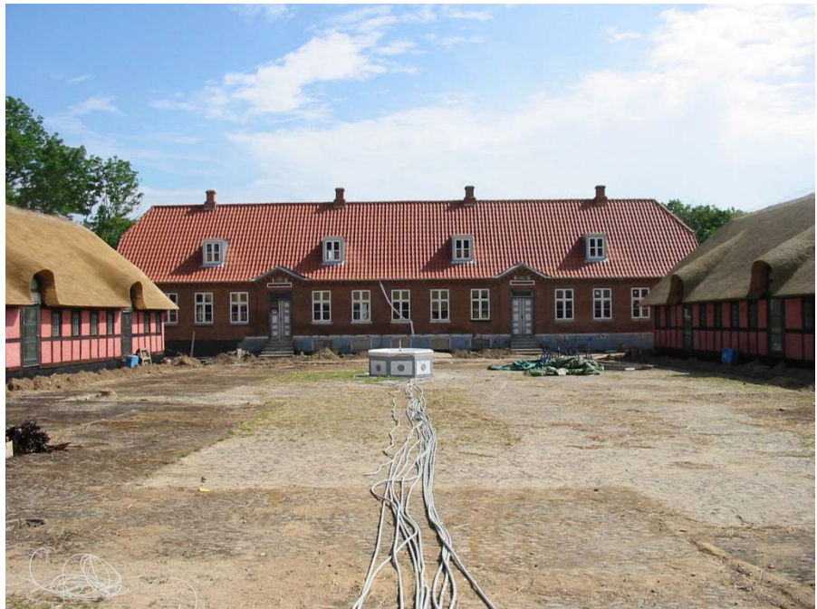
Skjødtgården er et nyt vartegn for Vestrup. Den er renoveret af Randers-egnens Boligforening med støtte fra Realdania Fonden. Gården er et godt eksempel på, at bevaring og udvikling kan forenes.
