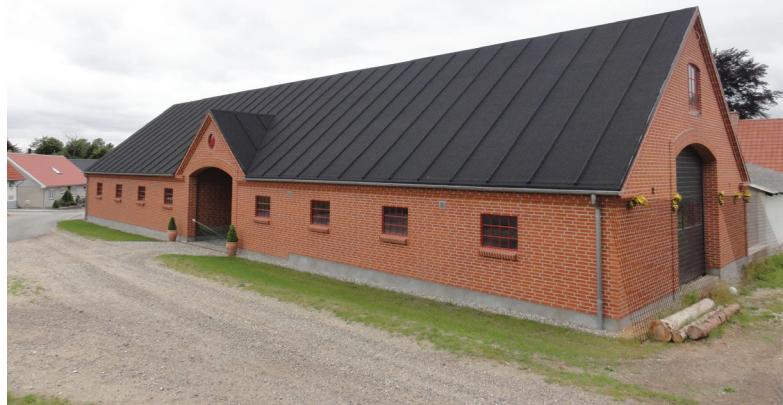
Pedersmindevej 13. To meget fine nyopførte længer tegner dette anlæg. Som man kan se, er der lagt både omtanke og økonomi i. Anlægget er med til at bevare en vigtig del af Kastbjergs struktur.
