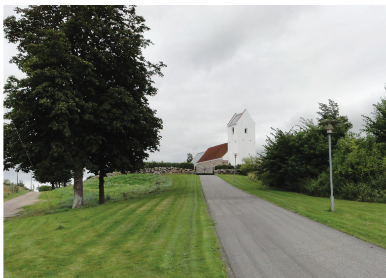
Kastbjerg Kirke med det grønne, tidligere ubebyggede forteareal i forgrunden.
