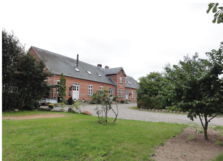
Den gamle skole, Bygaden 7 er opdelt i to beboelsesejendomme. Huset står meget originalt og er vurderet til en SAVE-værdi på 3.
