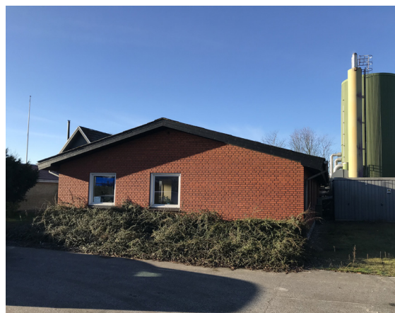
Varmekværkets nuværende bygninger og anlægs fremtræden set fra øst.
