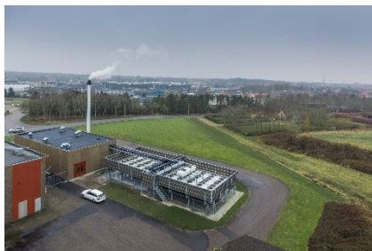
Referencefoto af energioptagere, som er omkranset af støjafskærmning
