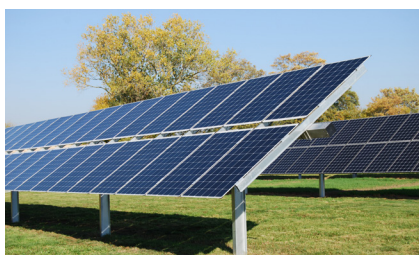
Solpaneler monteret på stativer med trackersystem
