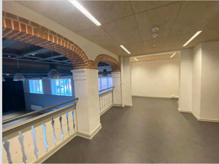
Balkon er svær at udnytte og præges af lydgener da der er direkte forbindelse til gymnastiksal og PLC. Det kan overvejes at skektionere arealerne med glasvæg.
