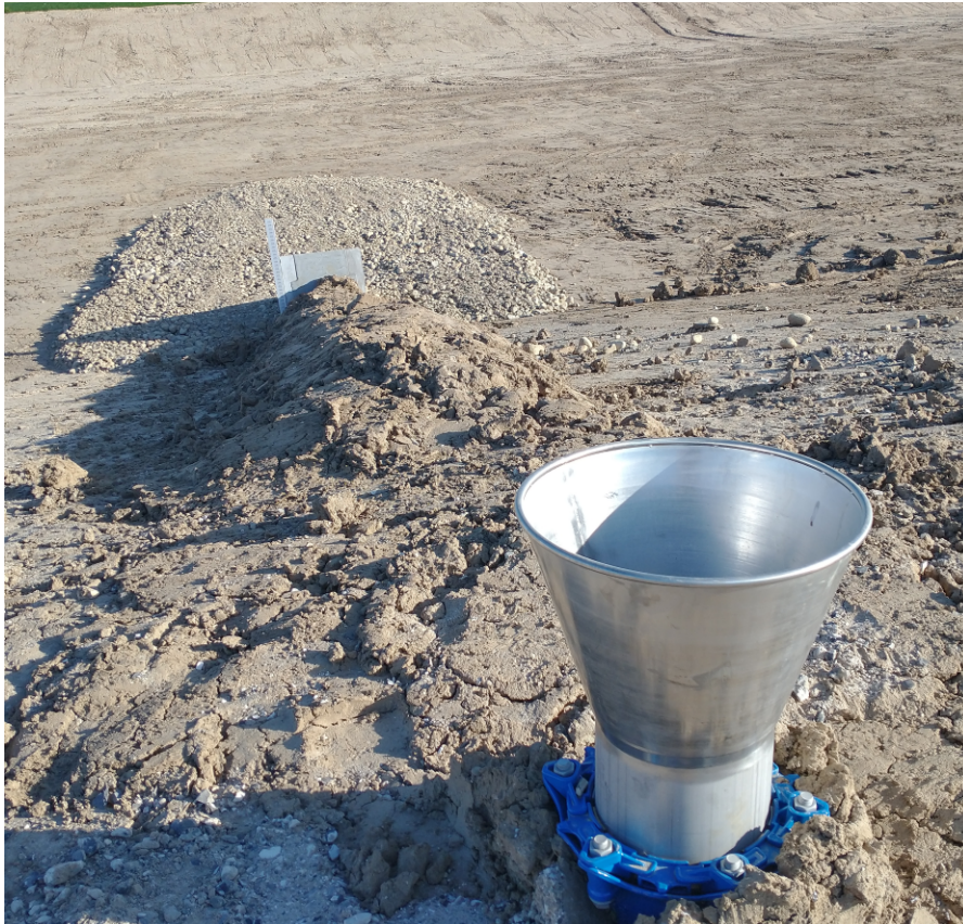
Billede 1. Bygværk til påfyldning og opsugning. Der er en tragt foroven på toppen af volden. Der er et skjult rør som udmunder nede i stenbedet. Stenbedets funktion er, at sprede vandet diffust ud, så man undgår erosion af bunden af bassinet. Membranen under bassinet holdes på plads af bundmaterialet. Der er også membran inde i brinkerne. Se vilkår 10-13 for påfyldning og opsugning i afsnit 1.2.3 – Brug af anlægget.
