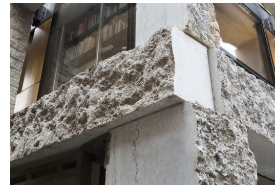
Natursten - konstruktivt og som beskyttelse mod vandet
