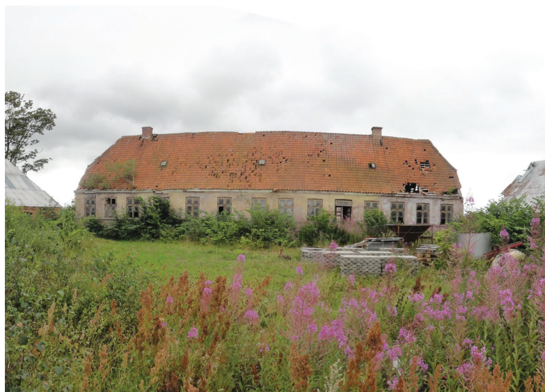
Mariagervej 355 har været forladt i en årrække og er i fremskreden forfald. Stuehuset er ,med sit enkle snit og 14 fag, ellers et flot eksempel på 1800-tallets gårdbyggeri.
